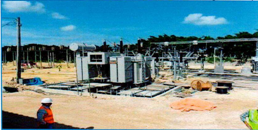
Ilustración 11-4. Transformador donde estarán conectadas las unidades de generación 9 y 10
