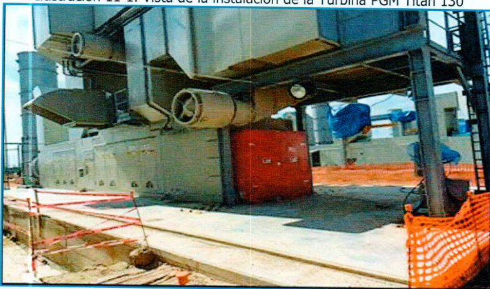
Ilustración 11-1. Vista de la instalación de la Turbina PGM Titan 130
